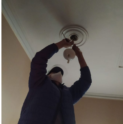
Figura 7. Trabajador en hogar reparando conexión eléctrica
