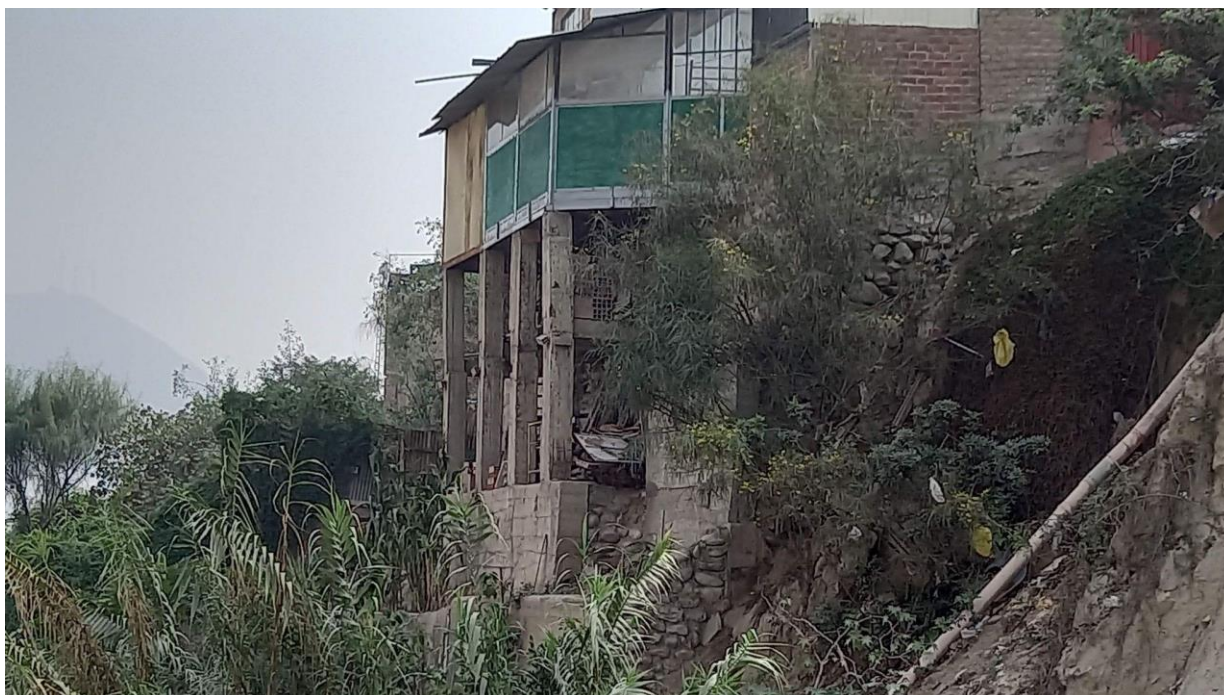
Vista desde el puente de una vivienda con columnas expuestas junto al río.
