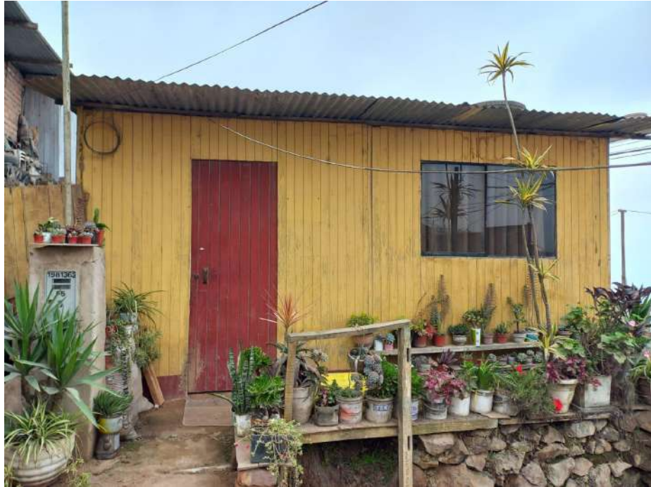
Vista de una vivienda con estructura de triplay y techo de calamina.
