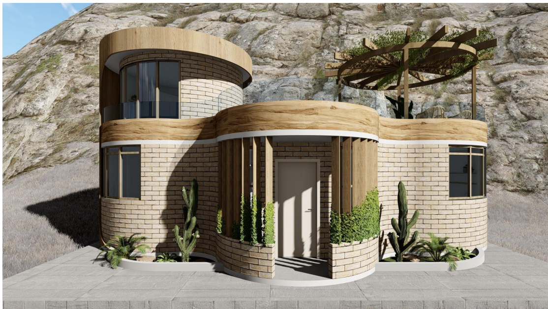
Figura 19. Vista frontal de la vivienda Bioarquitectónica
