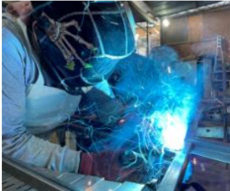
Figura 16. Fotografía referencial del proceso de soldadura de piezas metálicas.
