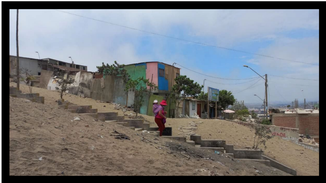
Vista del ingreso al Asentamiento humano 11 de Diciembre en Lomo de Corvina, se aprecia la condición de suelo como arenal.
