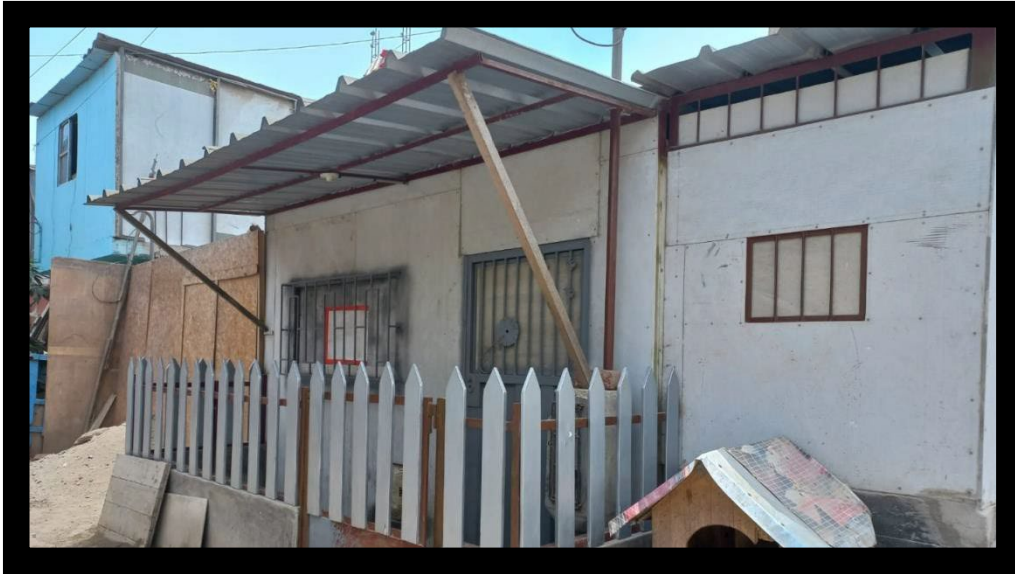
Vista de las viviendas a base de triplay y techo de calamina
